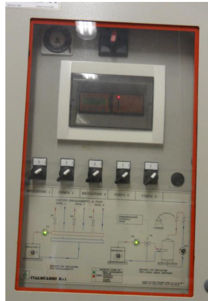
Figura 4.7 – Sistema di gestione e telecontrollo in CT
