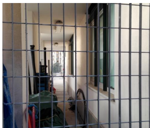
Figura 4.2 - Particolare del portico esposto a sud
