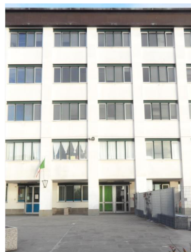
Figura 1.1 - Particolare della facciata principale esposta a Ovest
