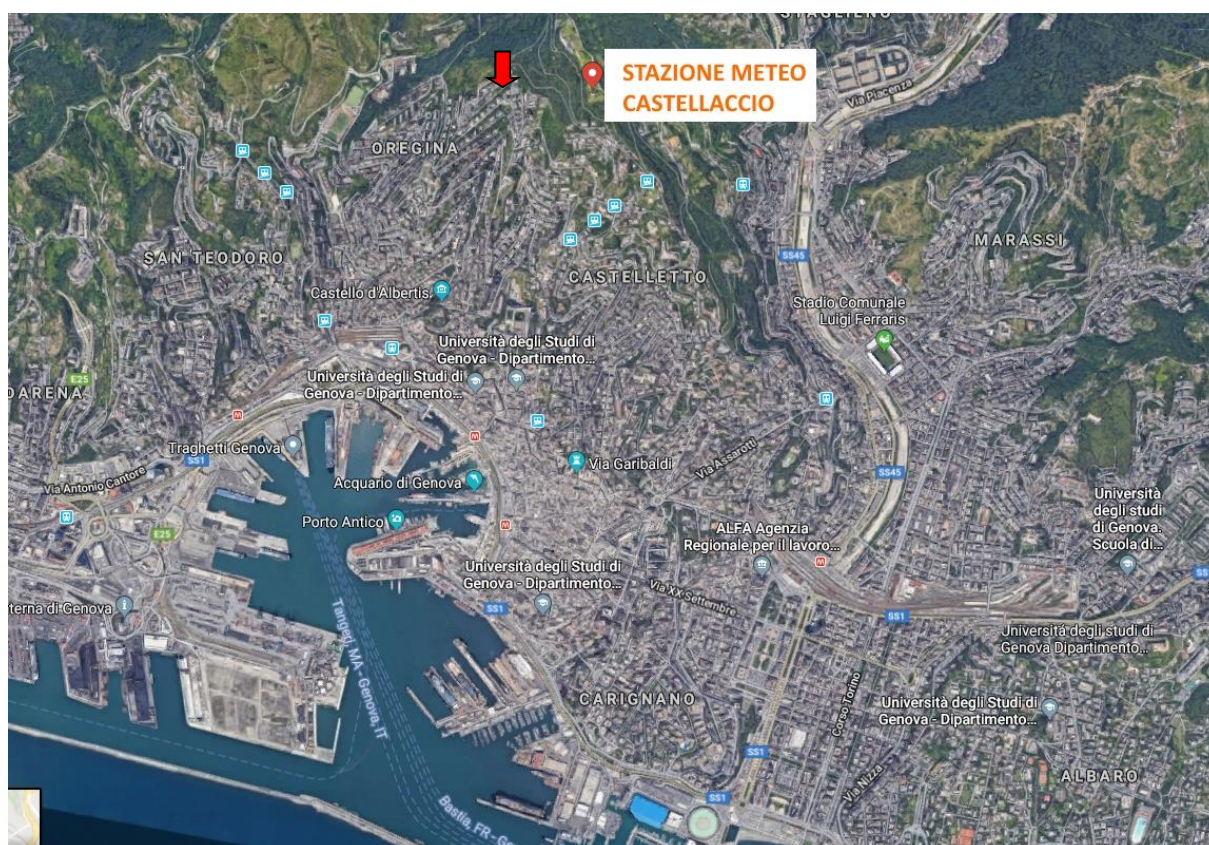
Figura 3.1 – Posizionamento della centralina meteo climatica rispetto all’edificio oggetto di DE
